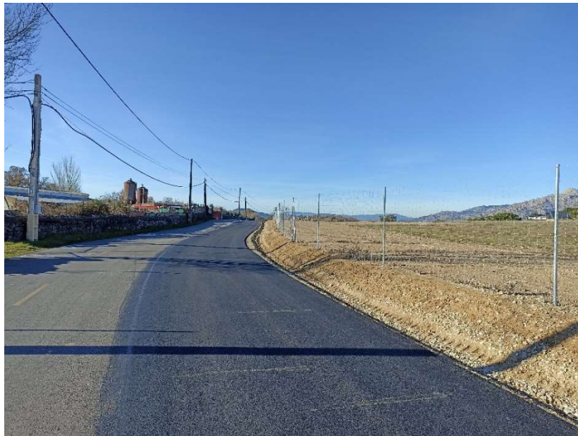
Camino del Valle, recientemente ampliado para instalar un carril bici, situado en la fachada Sur del ámbito. Fuente: Propia.
