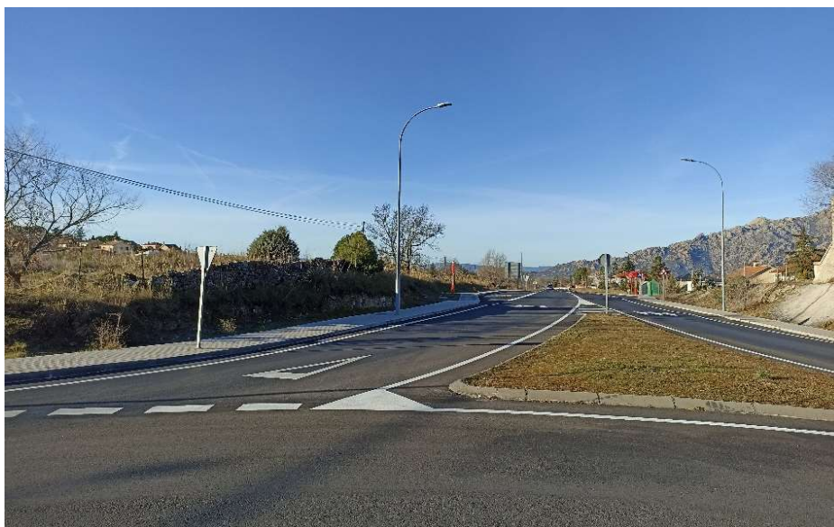
Calle Chozas de la Sierra situada en la fachada Este del ámbito.
